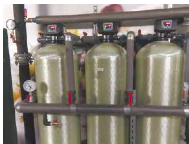
Комплексная станция водоподготовки производительностью 5 м 3 /ч для пищевого производства (обезжелезивание, удаление нерастворенных примесей, тонкая очистка, УФ-обеззараживание)
