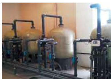
Станция обезжелезивания хозяйственно-питьевого назначения производительностью 2200 м 3 /сутки
