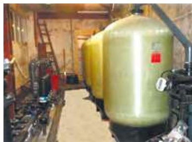
Станция обезжелезивания хозяйственно-питьевого назначения производительностью 2800 м 3 /сутки
